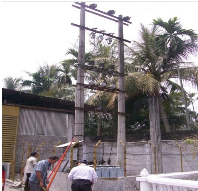
Gambar 1. Persiapan untuk naik ke atas mengecek keadaan listrik Dokumentasi PT. PLN Cabang Binjai (sumber hasil riset)
